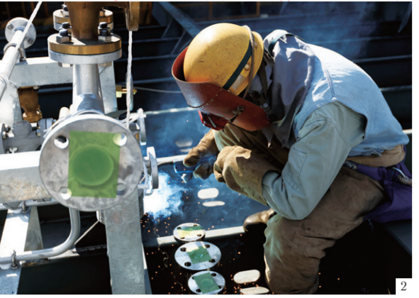
1.浅野さんのいつもの仕事スタイル 2.狭い船上での溶接は小柄な人に向いている 3.キレイに仕上がった溶接部分とはこんな感じだとか
