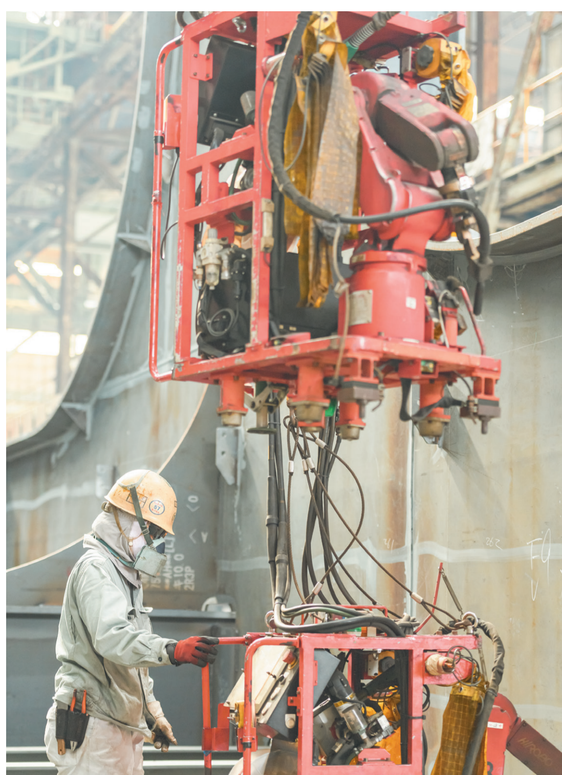
「自動溶接機を使ってデータを入力すれば、自動で溶接が可能です。ずいぶん楽になりました」(中島さん)
