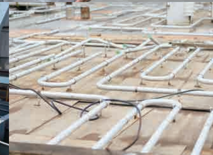
船の内部の配管
