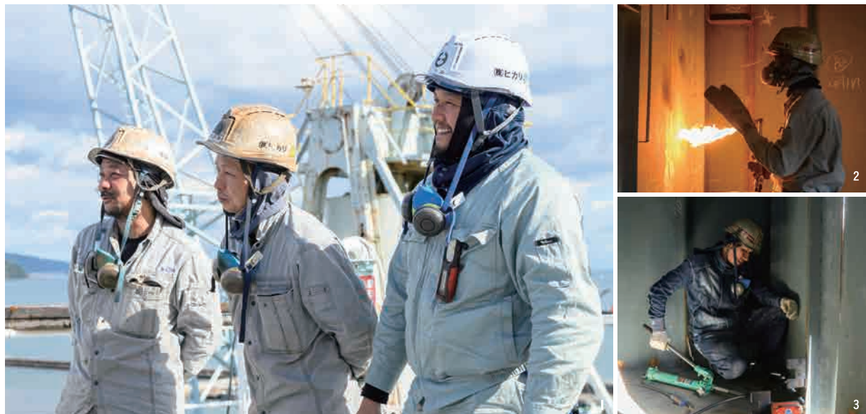
1.チーム作業の現場は作業員同士、声をかけ合い和気あいあいとした雰囲気に 2.3.「多能工」の育成がヒカリの方針。溶接、取付と幅広い技能を身につけられる環境がある
